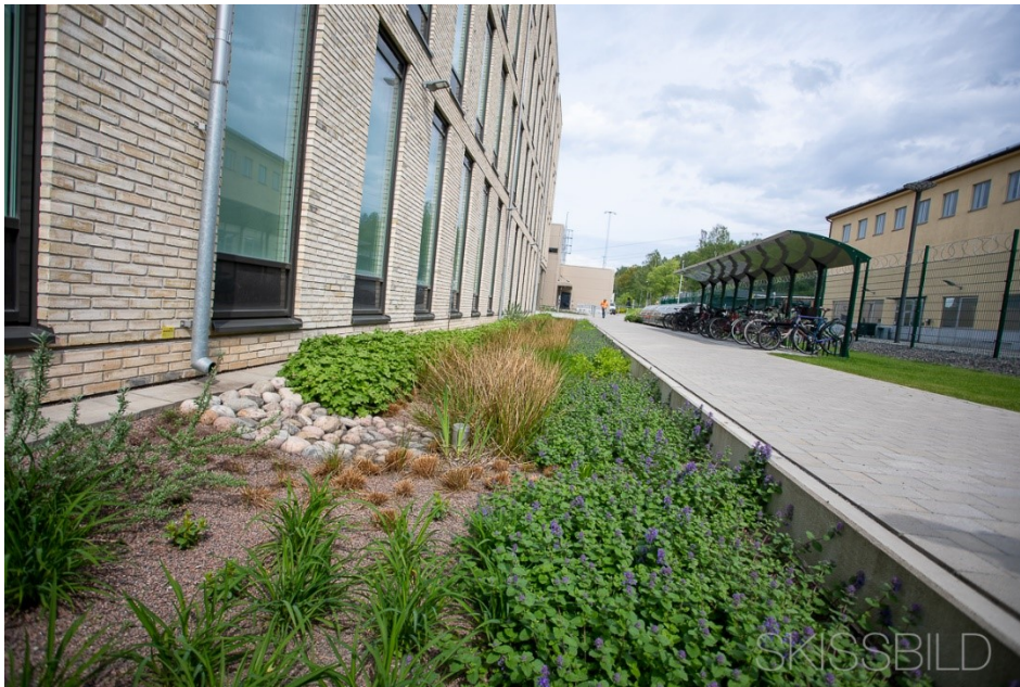
Figur 12 Nedsänkt regnrabatt utanför Kretslopp och vattens kontor som hanterar dagvatten från takytor och mark. Foto: SKISSBILD
