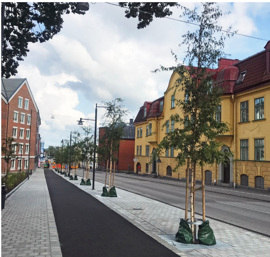
Figur 14 Träd i hårdgjord yta. Södra järnvägs-gatan, Växjö. Under betongplattor genomgående öppet förstärkningslager med biokol, under G/C-väg öppet förstärkningslager. Dagvatten leds in via rännor till luftdagvattenbrunnar. Foto: Örjan Stål från "Levande gaturum – en handbok i Blågröngrå system" av Edge
