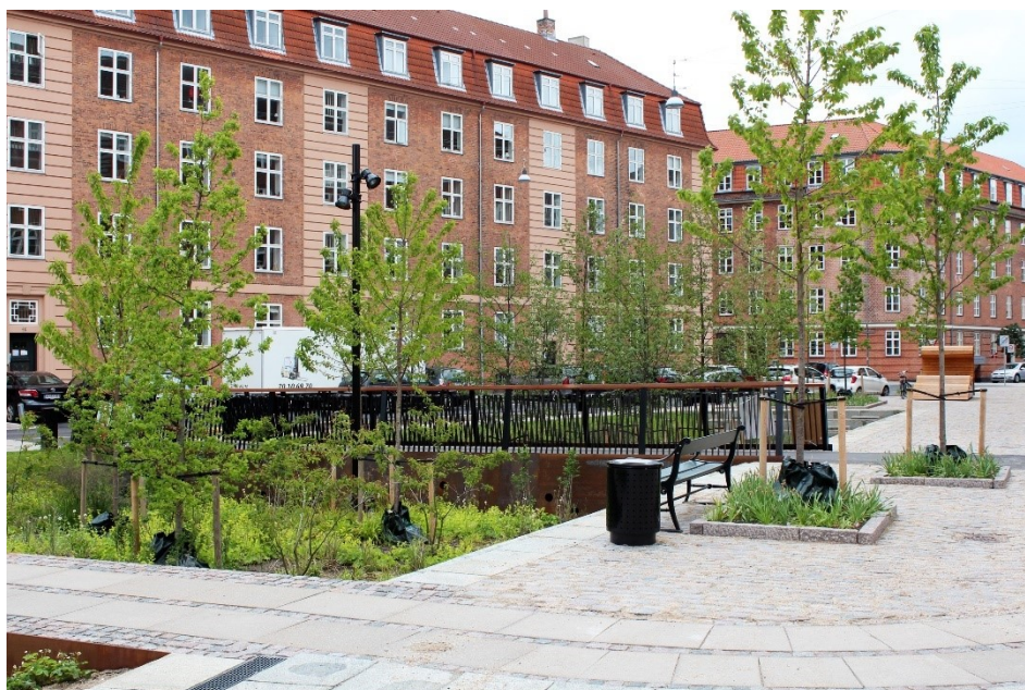
Figur 15 Tåsinge plats i Köpenhamn. Området utgörs av en före detta parkering som gjorts om till en multifunktionell yta för dagvatten- och skyfallshantering samt rekreation. Bildkälla: (Klimatkvarter, 2022)
